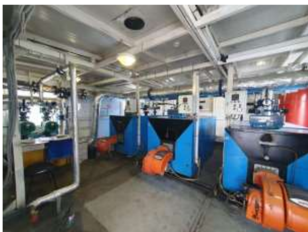
Фото №63 Здание (Котельная), кадастровый номер: 23:43:0109002:454 (внутренняя отделка)
