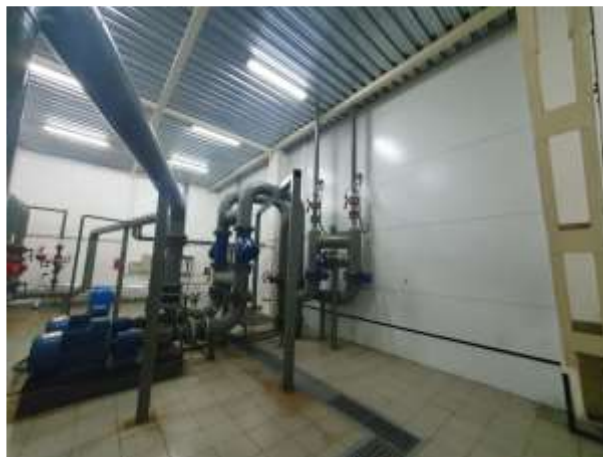
Фото №86 Сооружение (Пожарный водопровод), кадастровый номер: 23:43:0109002:482
