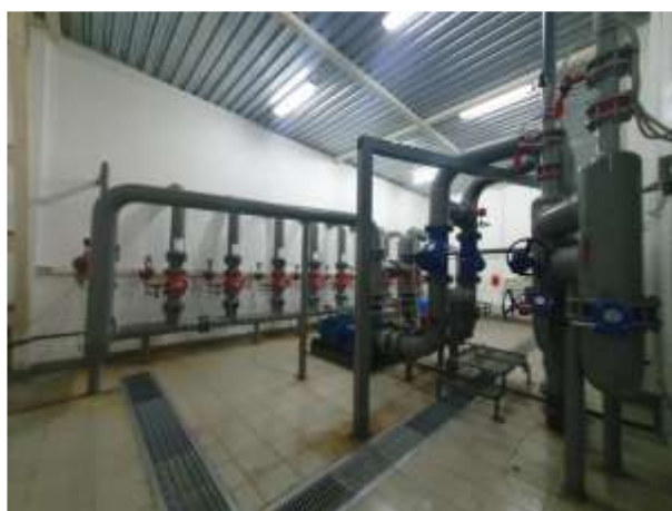
Фото №84 Сооружение (Пожарный водопровод), кадастровый номер: 23:43:0109002:482
