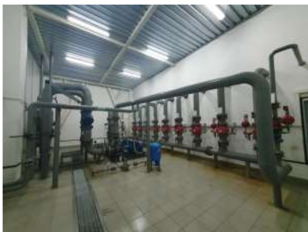
Фото №81 Сооружение (Пожарный водопровод), кадастровый номер: 23:43:0109002:482
