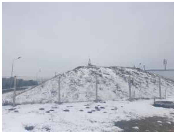
Фото №98 Сооружение (Пожарный резервуар №1), кадастровый номер: 23:43:0109002:472
