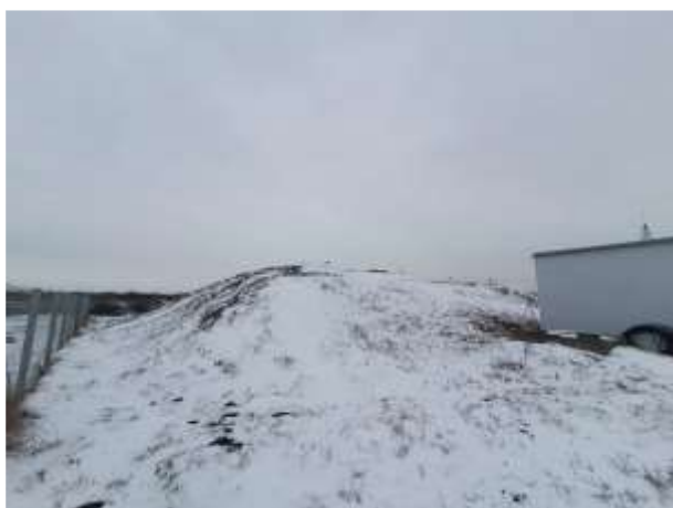
Фото №99 Сооружение Пожарный резервуар №2 кадастровый номер: 23:43:0109002:459.
