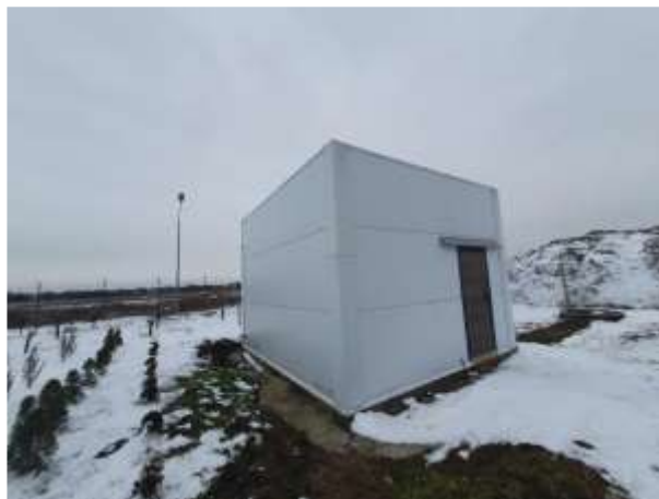
Фото №74 Здание (Насосная), кадастровый номер: 23:43:0109002:452 (общий вид)
