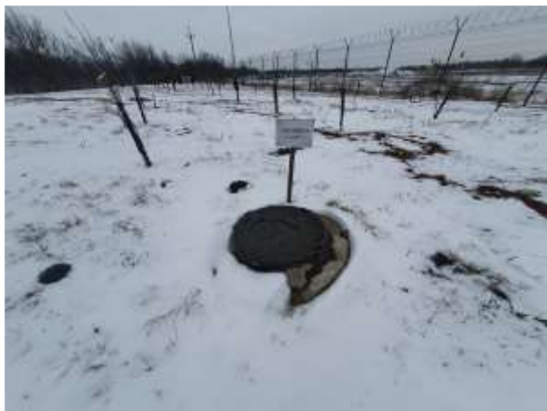
Фото №109 Сооружение (Скважина 3), кадастровый номер: 23:43:0109002:514
