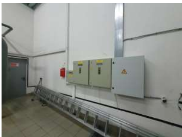
Фото №87 Сооружение (Пожарный водопровод), кадастровый номер: 23:43:0109002:482
