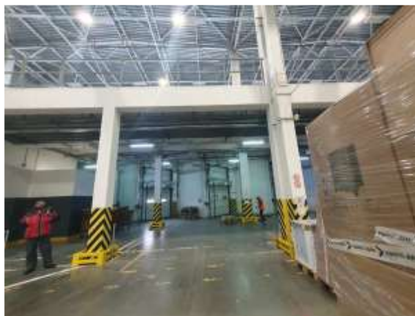
Фото №18 Здание (Склад 2), 23:43:0109002:303 (внутренняя отделка)
