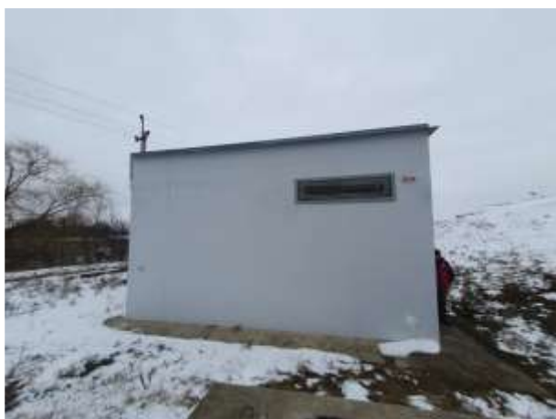
Фото №93 Здание (Пожарная насосная), кадастровый номер: 23:43:0109002:453
