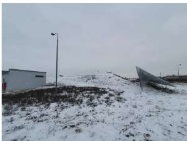
Фото №95 Сооружение (Пожарный резервуар №1), кадастровый номер: 23:43:0109002:472
