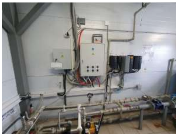
Фото №72 Здание (Насосная), кадастровый номер: 23:43:0109002:452
