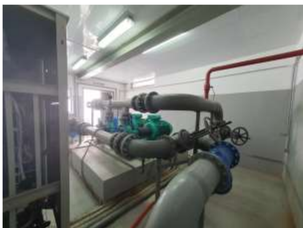
Фото №91 Здание (Пожарная насосная), кадастровый номер: 23:43:0109002:453
