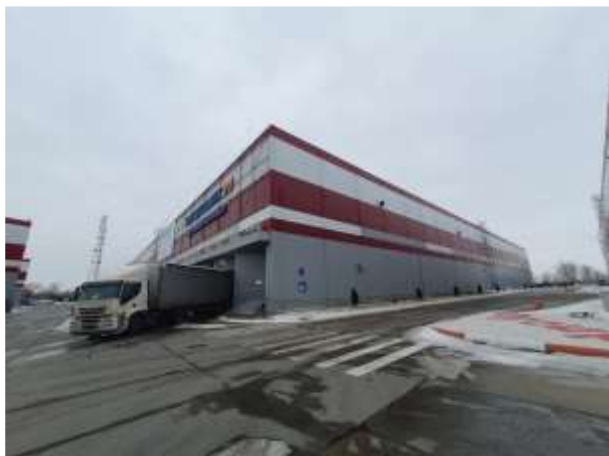
Фото №3 Здание (Склад 1), 23:43:0109002:261 (общий вид)
