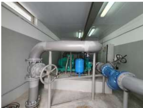
Фото №89 Здание (Пожарная насосная), кадастровый номер: 23:43:0109002:453
