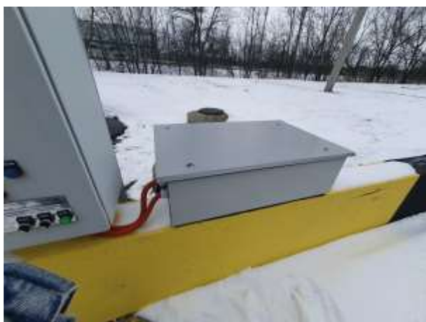
Фото №79 Сооружение (Очистные сооружения), кадастровый номер: 23:43:0109002:455
