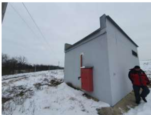
Фото №94 Здание (Пожарная насосная), кадастровый номер: 23:43:0109002:453
