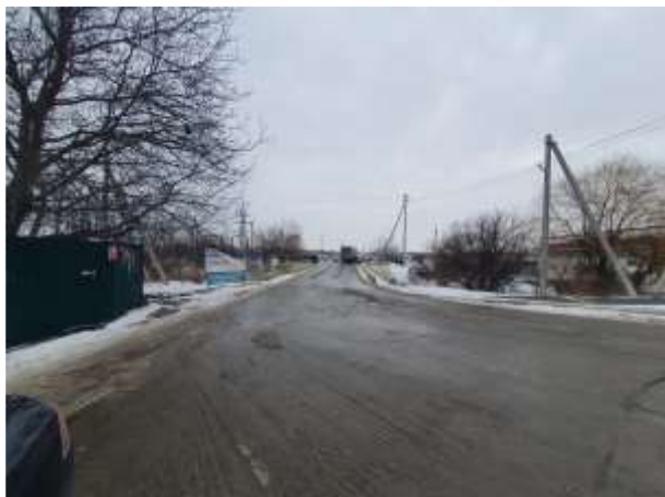
Фото №1 Подъездные пути к объекту
