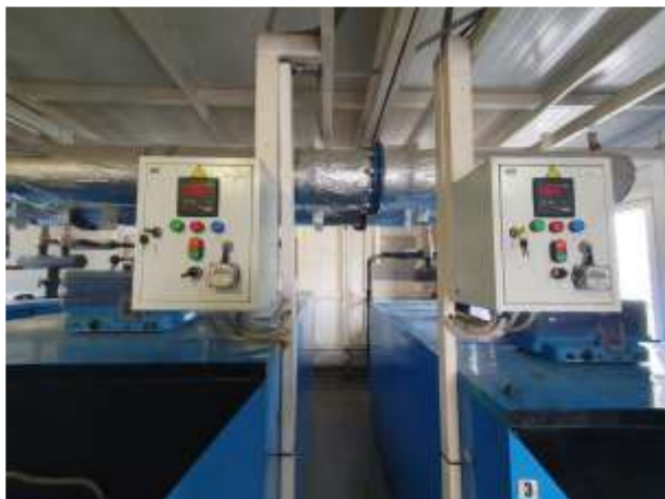
Фото №61 Здание (Котельная), кадастровый номер: 23:43:0109002:454 (внутренняя отделка)
