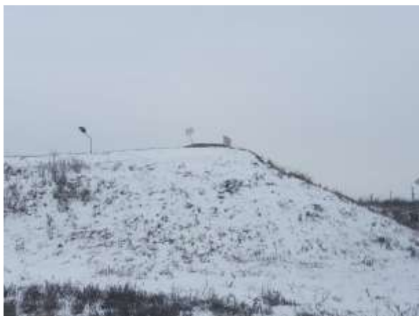
Фото №101 Сооружение Пожарный резервуар №2 кадастровый номер: 23:43:0109002:459
