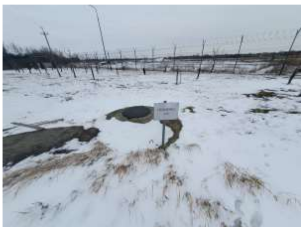
Фото №111 Сооружение (Скважина 4), кадастровый номер: 23:43:0109002:483
