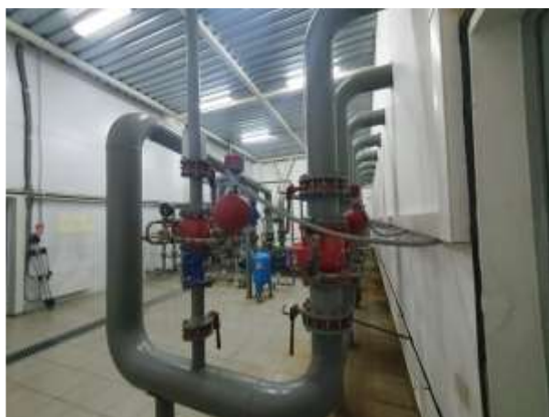
Фото №82 Сооружение (Пожарный водопровод), кадастровый номер: 23:43:0109002:482
