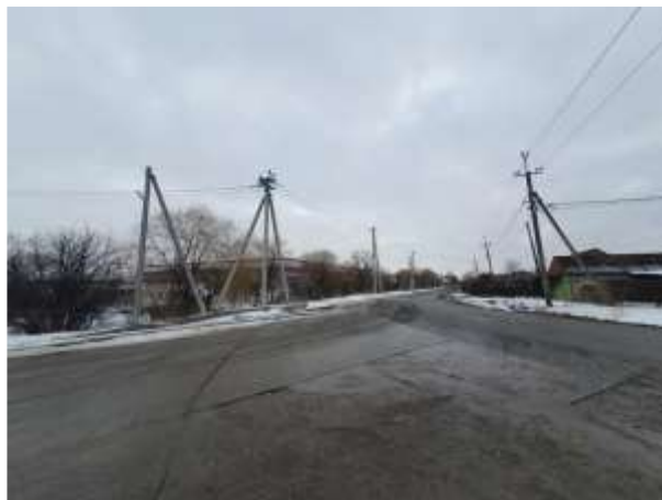
Фото №2 Подъездные пути к объекту
