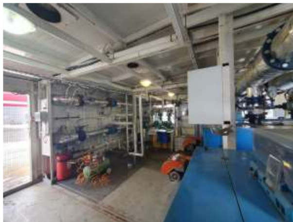
Фото №62 Здание (Котельная), кадастровый номер: 23:43:0109002:454 (внутренняя отделка)
