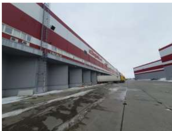
Фото №8 Здание (Склад 1), 23:43:0109002:261 (общий вид)
