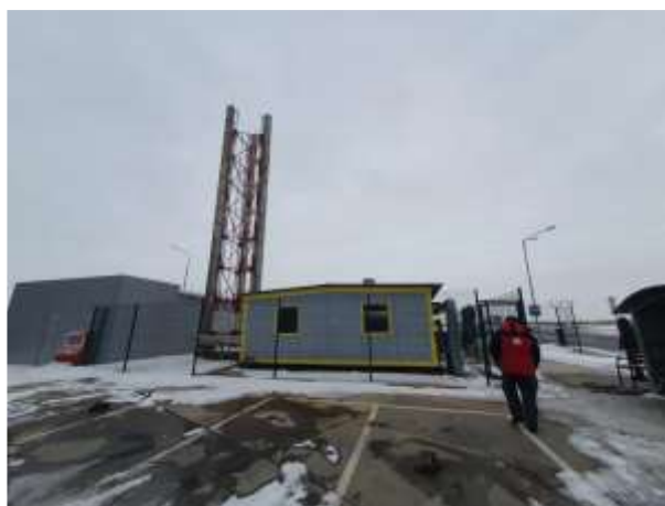
Фото №58 Здание (Котельная), кадастровый номер: 23:43:0109002:454
