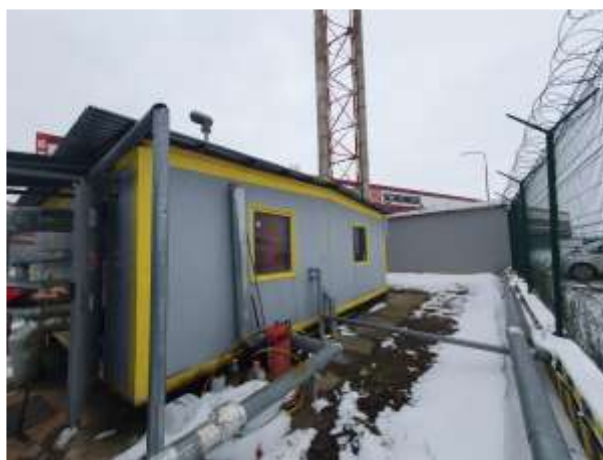
Фото №64 Здание (Котельная), кадастровый номер: 23:43:0109002:454 (общий вид)
