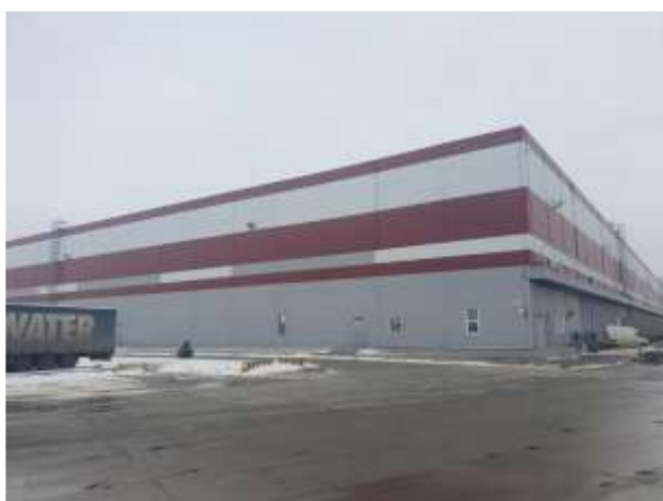
Фото №9 Здание (Склад 2), 23:43:0109002:303 (общий вид)
