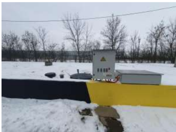
Фото №77 Сооружение (Очистные сооружения), кадастровый номер: 23:43:0109002:455
