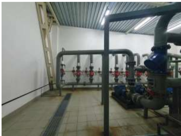
Фото №85 Сооружение (Пожарный водопровод), кадастровый номер: 23:43:0109002:482
