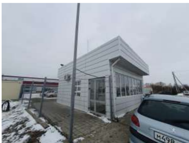
Фото №67 Здание (КПП), кадастровый номер: 23:43:0109002:460
