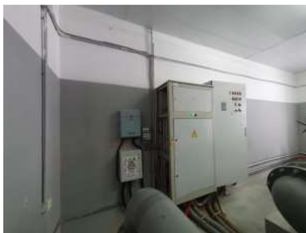
Фото №92 Здание (Пожарная насосная), кадастровый номер: 23:43:0109002:453
