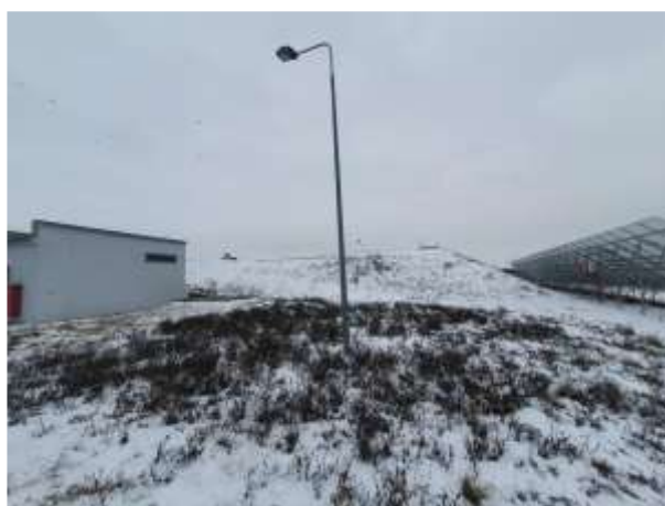
Фото №96 Сооружение (Пожарный резервуар №1 кадастровый номер: 23:43:0109002:472
