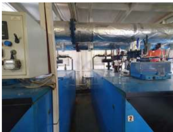
Фото №60 Здание (Котельная), кадастровый номер: 23:43:0109002:454 (внутренняя отделка)
