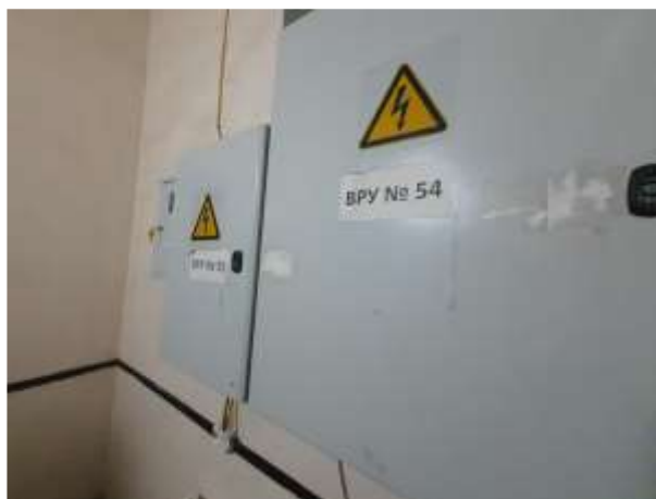
Фото №12 Здание (Склад 2), 23:43:0109002:303 (внутренняя отделка)
