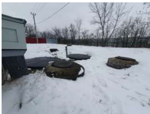
Фото №80 Сооружение (Очистные сооружения), кадастровый номер: 23:43:0109002:455
