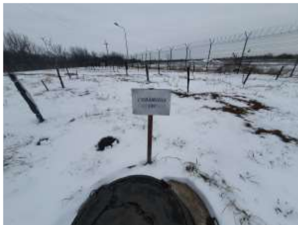
Фото №110 Сооружение (Скважина 3), кадастровый номер: 23:43:0109002:514
