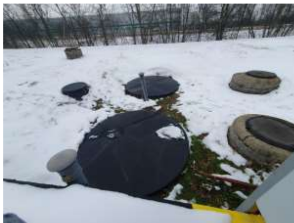
Фото №78 Сооружение (Очистные сооружения), кадастровый номер: 23:43:0109002:455
