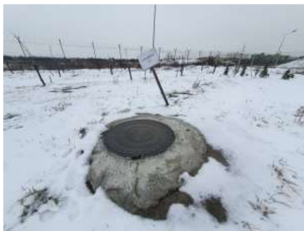
Фото №108 Сооружение (Скважина 2), кадастровый номер: 23:43:0109002:515
