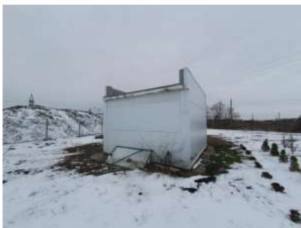
Фото №75 Здание (Насосная), кадастровый номер: 23:43:0109002:452 (общий вид)
