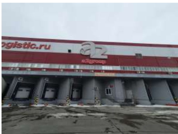
Фото №7 Здание (Склад 1), 23:43:0109002:261 (общий вид)
