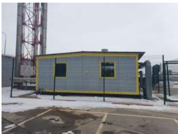
Фото №57 Здание (Котельная), кадастровый номер: 23:43:0109002:454
