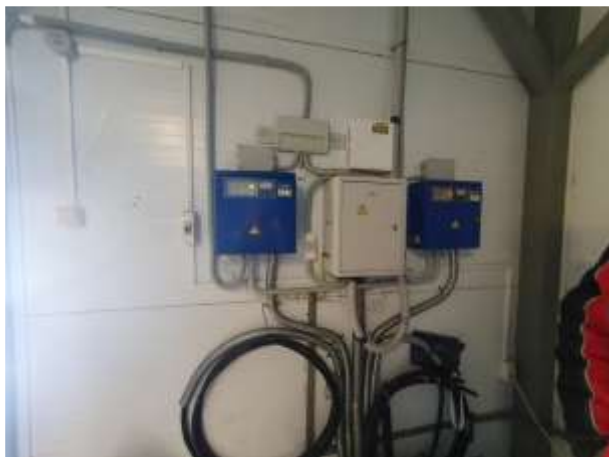
Фото №73 Здание (Насосная), кадастровый номер: 23:43:0109002:452 (Внутренняя отделка)
