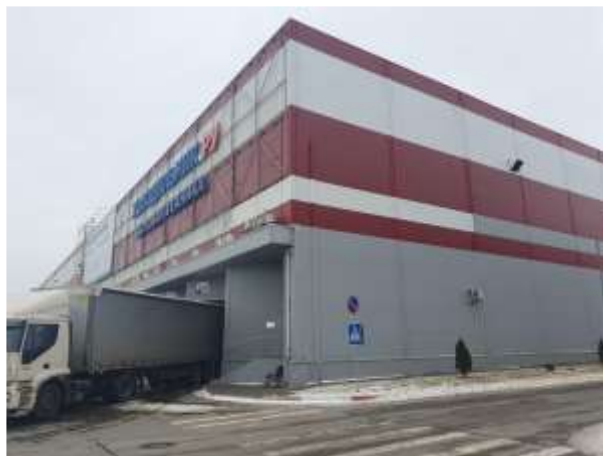
Фото №4 Здание (Склад 1), 23:43:0109002:261 (общий вид)
