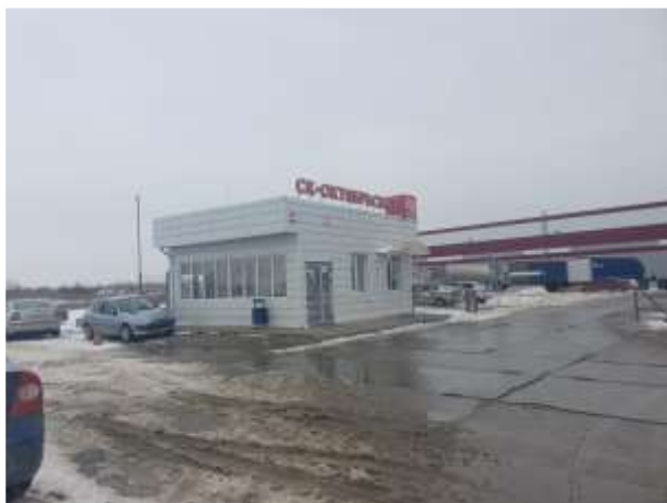
Фото №65 Здание (КПП), кадастровый номер: 23:43:0109002:460
