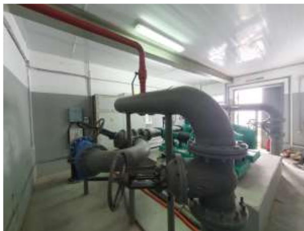
Фото №90 Здание (Пожарная насосная), кадастровый номер: 23:43:0109002:453
