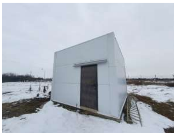
Фото №76 Здание (Насосная), кадастровый номер: 23:43:0109002:452 (общий вид)
