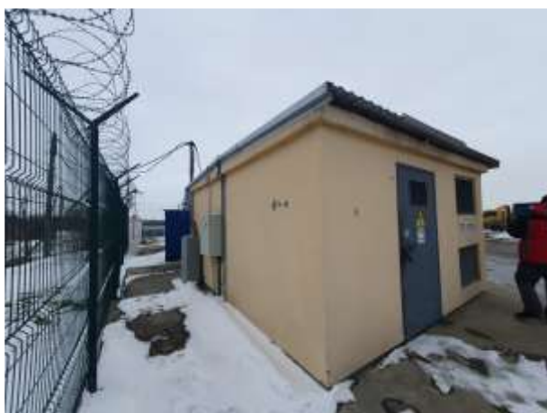
Фото №115 Здание (Трансформаторная подстанция), кадастровый номер: 23:43:0109002:450
