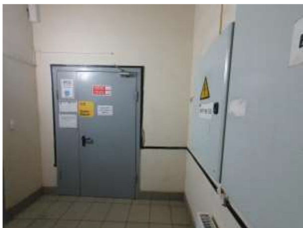
Фото №11 Здание (Склад 2), 23:43:0109002:303 (внутренняя отделка)
