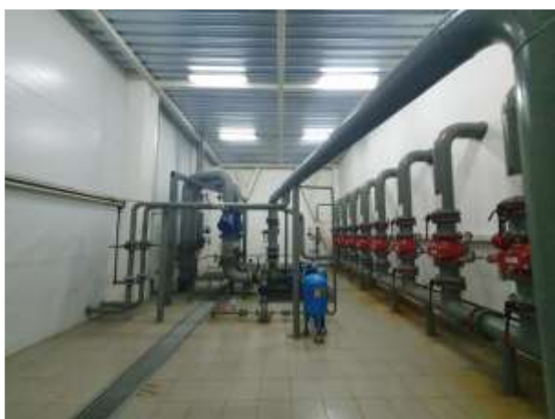
Фото №83 Сооружение (Пожарный водопровод), кадастровый номер: 23:43:0109002:482
