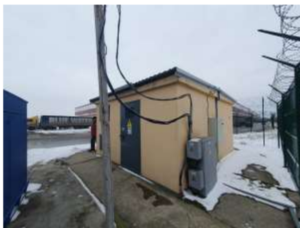
Фото №116 Здание (Трансформаторная подстанция), кадастровый номер: 23:43:0109002:450
