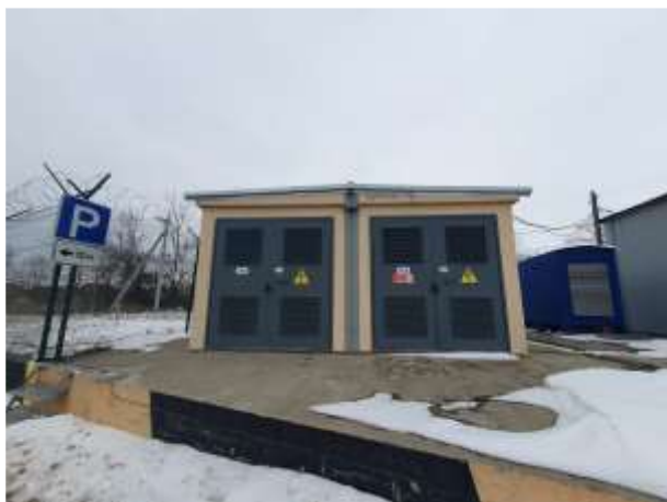
Фото №113 Здание (Трансформаторная подстанция), кадастровый номер: 23:43:0109002:450
