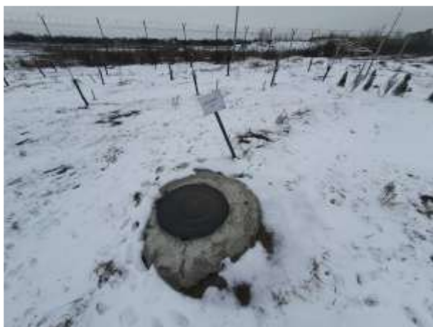
Фото №107 Сооружение (Скважина 2), кадастровый номер: 23:43:0109002:515
