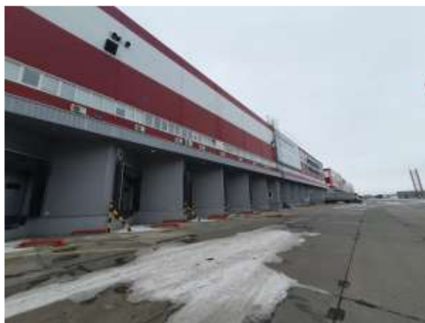
Фото №6 Здание (Склад 1), 23:43:0109002:261 (общий вид)
