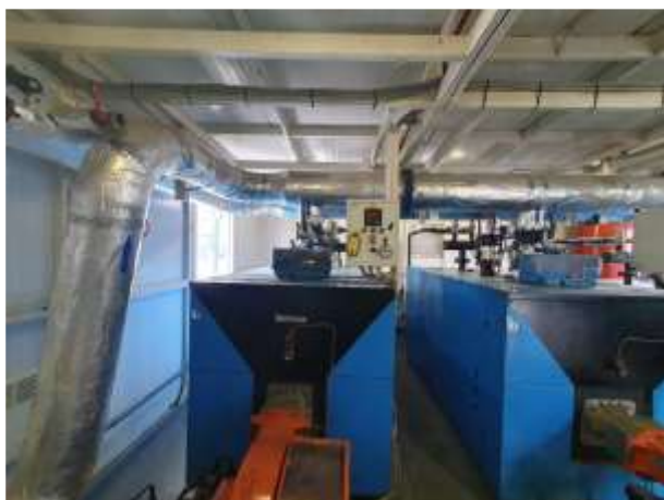
Фото №59 Здание (Котельная), кадастровый номер: 23:43:0109002:454 (внутренняя отделка)
