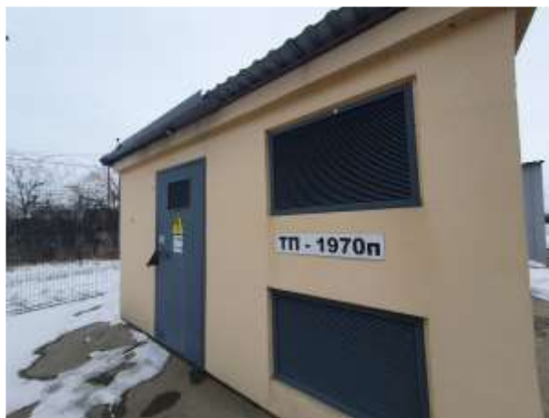
Фото №114 Здание (Трансформаторная подстанция), кадастровый номер: 23:43:0109002:450
