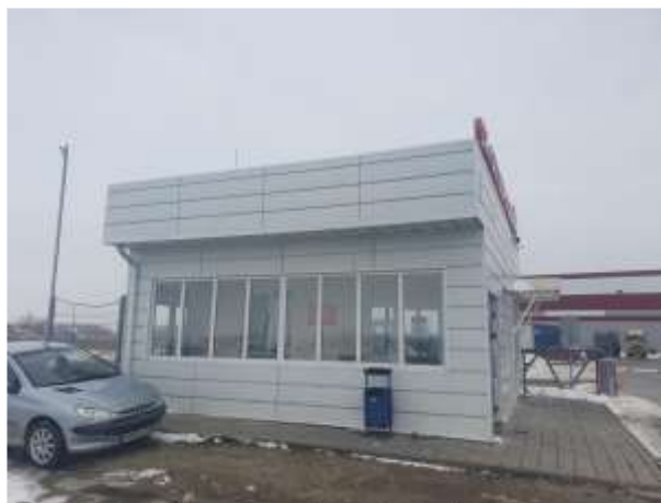
Фото №66 Здание (КПП), кадастровый номер: 23:43:0109002:460
