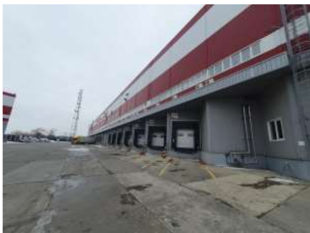
Фото №5 Здание (Склад 1), 23:43:0109002:261 (общий вид)
