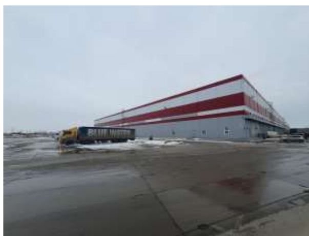
Фото №10 Здание (Склад 2), 23:43:0109002:303 (общий вид)
