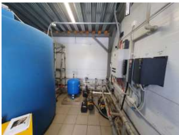
Фото №71 Здание (Насосная), кадастровый номер: 23:43:0109002:452
