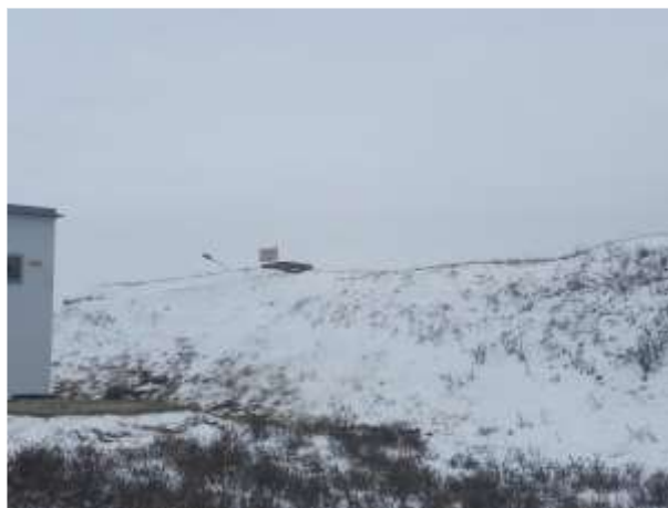
Фото №102 Сооружение Пожарный резервуар №2 кадастровый номер: 23:43:0109002:459
